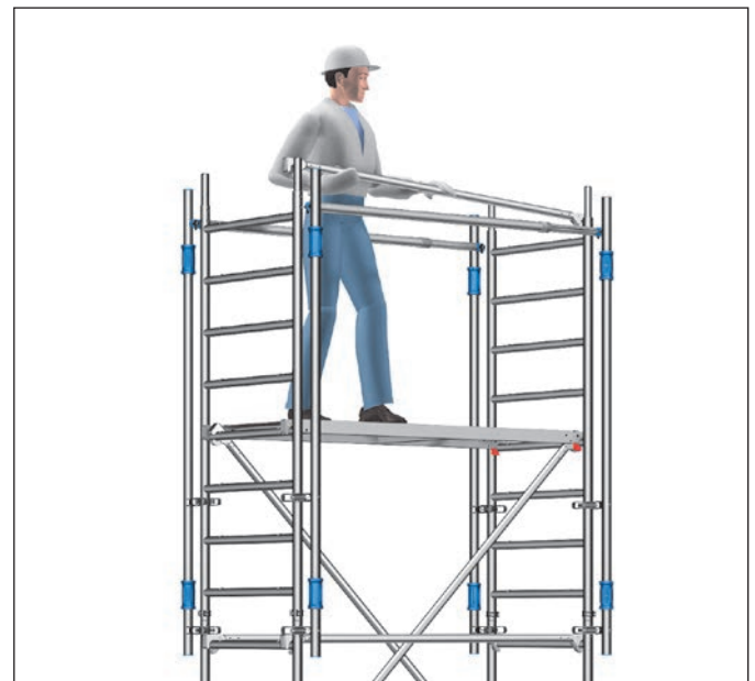
Bild 6: Sichere Montage der Rückenlehnen mit MSG
