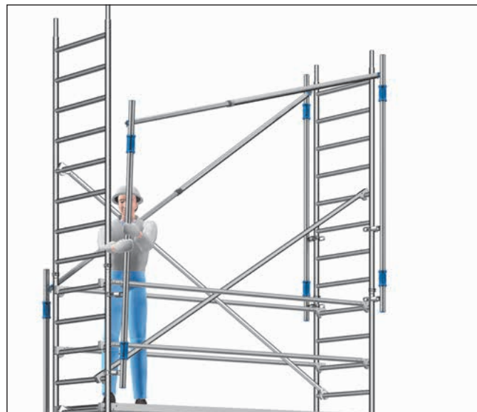
Bild 5: Versetzen des MSG nach oben
