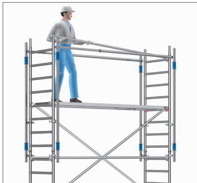
Bild 6: Sichere Montage der Rückenlehnen mit MSG
