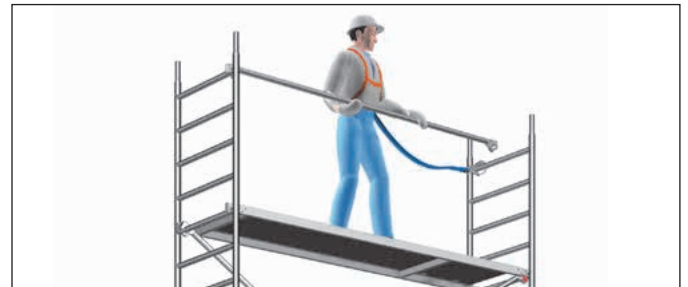
Bild 3: Sichere Montage der Rückenlehnen mit PSA
